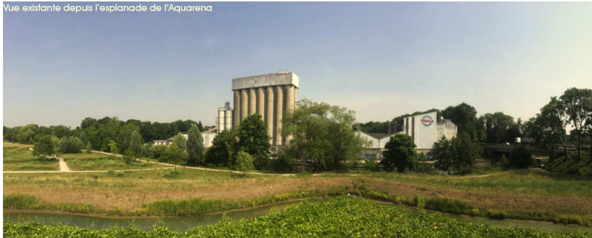
Vue existante depuis l'esplanade de l'Aquarena
